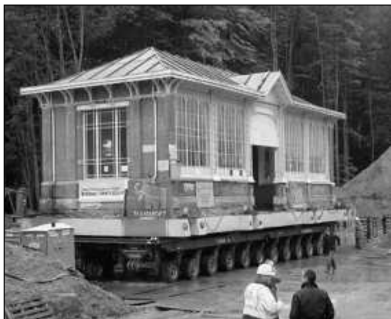
Petit à petit, le RER fait son nid. Pour mieux préparer son arrivée, la SNCB a délicatement fait déplacer l'abri de la gare de Groenendael sur une centaine de roues. Classé à la fin du 19 ème siècle, il est ainsi épargné par les travaux de l'élargissement de la voie. (DR)
